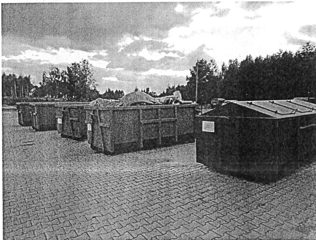
Zdjęcie nr 4. Kontenery typu KP7 na: tekstylia (kod odpadu 20 01 11), opakowania z tworzyw sztucznych (kod odpadu 15 01 02), opakowania ze szkła (kod odpadu 15 01 07), żużle i popioły (kod odpadu 10 01 01), odpady betonu i gruzu (kod odpadu 17 01 01).
